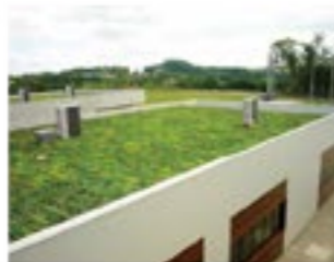
Cobertura vegetal para redução da temperatura nos ambientes internos.
