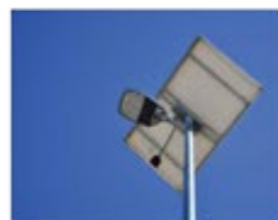
Iluminação autônoma, formada por células fotovoltaicas.
